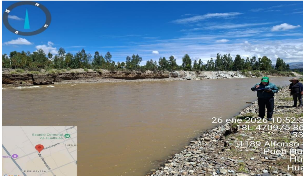
FIGURA N°02: La margen derecha del río Mantaro en el sector Puquiales presenta alto riesgo de inundación ,no existen defensas ribereñas y el borde se encuentra erosionado, esponiando las areas agrícolas cercanas
