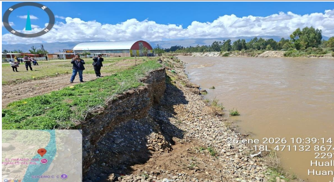
FIGURA N°01: La margen izquierda del río Mantaro en el sector Puquiales presenta alto riesgo de inundación debido a la elevación del lecho del río, no existen defensas ribereñas y el borde se encuentra erosionado, esponiendo la población cercana
